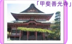
日本有数の木造建築と日本一の鳴き龍「甲斐善光寺」
