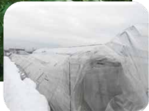
(H26.2月の大雪で倒壊したハウス)
