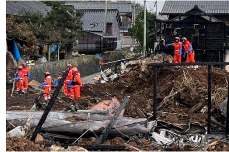
緊急消防援助隊 (倒壊家屋等からの救出・救助活動等)
