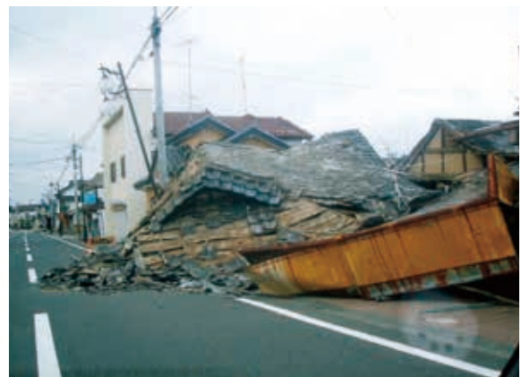
Danos causados pelo Grande Terremoto do Leste do Japão
