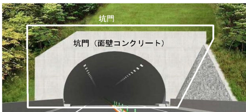
図3-3 点検対象箇所（トンネル坑口部）
