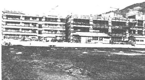
新学期開校に備え北西中の工事進む
