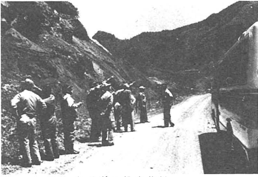
荒川ダム視察状況
