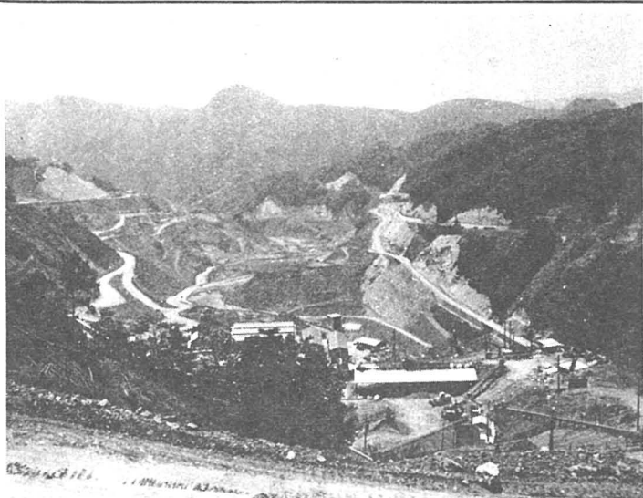
急ピッチで建設が進む荒川多目的ダム
