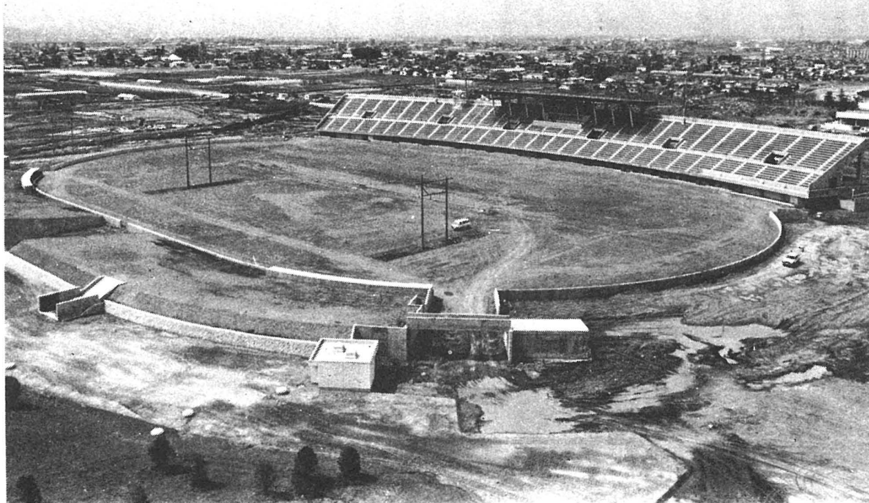
昭和61年「かいじ国体」をめざし、工事が進むメイン会場
