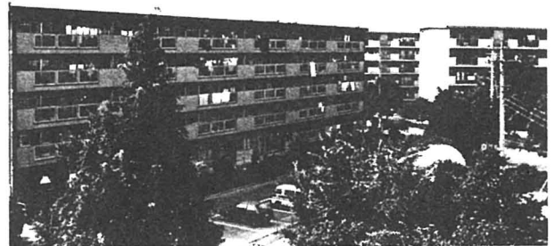
〈市営住宅（後屋団地）〉
