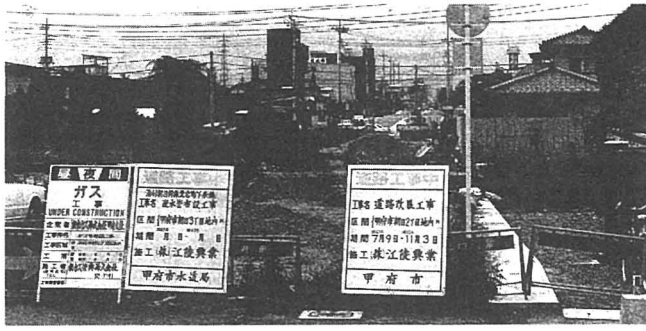
〈工事中の愛宕町下条線〉
