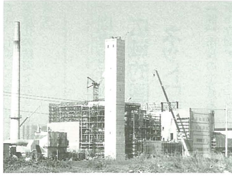
建設中の新清掃工場
