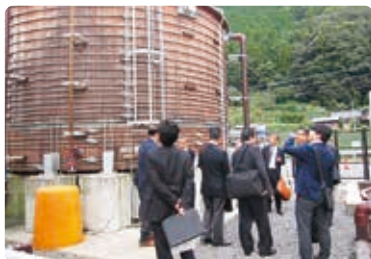
環境水道委員会による視察の様子 (島田市「メタンガス発電施設」)
