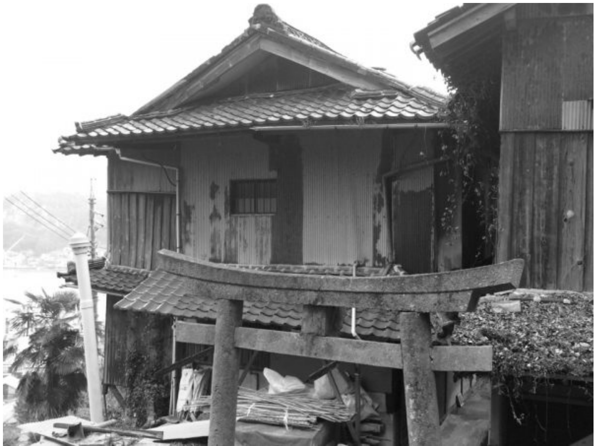
「みはらし亭」は、建築当初は茶園（別荘建築）として利用され、その後料亭となり戦後は旅館として活用されていた。築100年をこえるこの建物は、坂の上という立地の不便さと老朽化から20年近く空き家となっていた（写真提供：尾道空き家再生プロジェクト）
