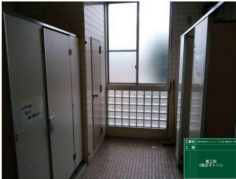
着工前 2階女子トイレ
