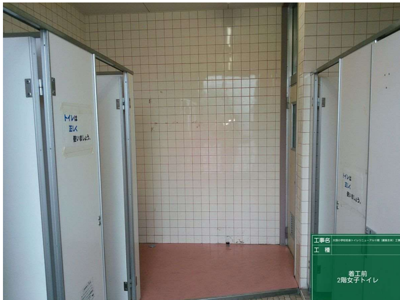
着工前 2階女子トイレ
