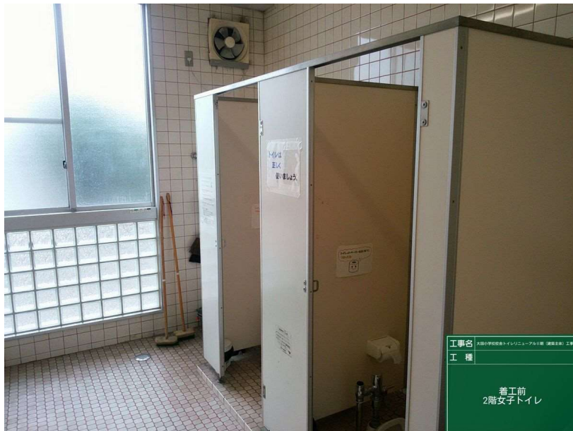
着工前 2階女子トイレ
