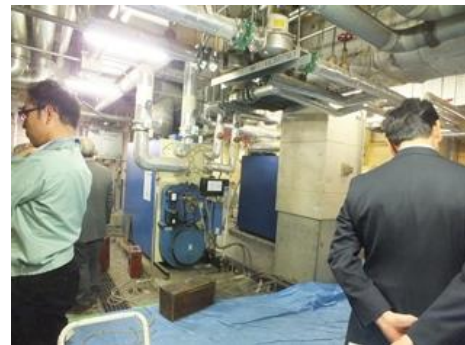
木質ボイラー導入診断の様子
