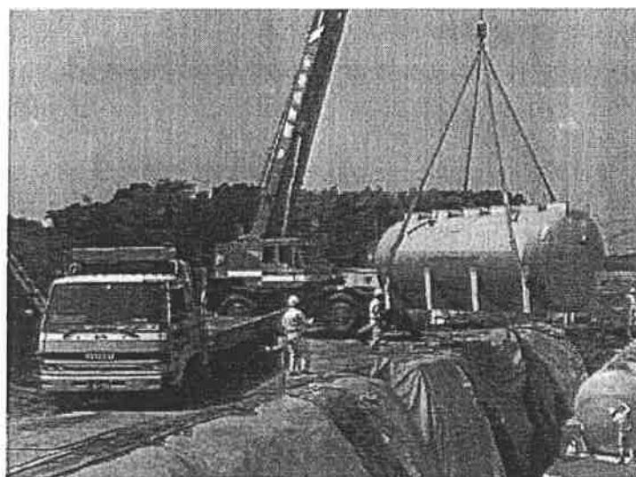
図 3-6 規模の大きな淨化槽の例（設置工事中）
