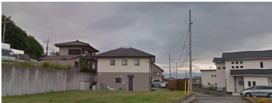
電柱・支線状況
