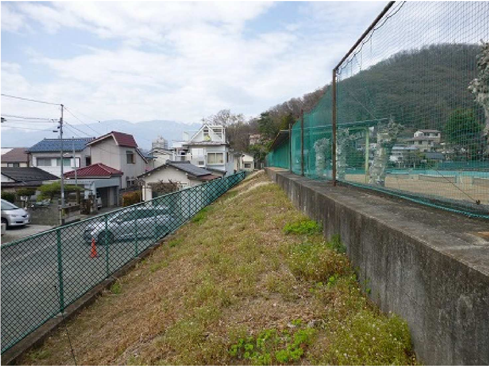
ネットフェンスのみ撤去 H=1.50m L=124.62m (下部擁壁は存置)
