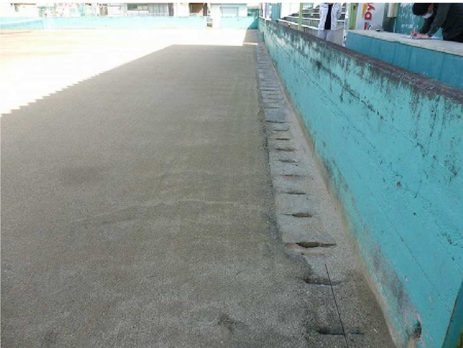
⑥ コンクリート側溝 内幅360mm×深さ平均300mm 溝蓋付・現場打ち (113,860 - 150 -150) ×2 + (38,040 - 360 -360) ×2 = 301,760mm
