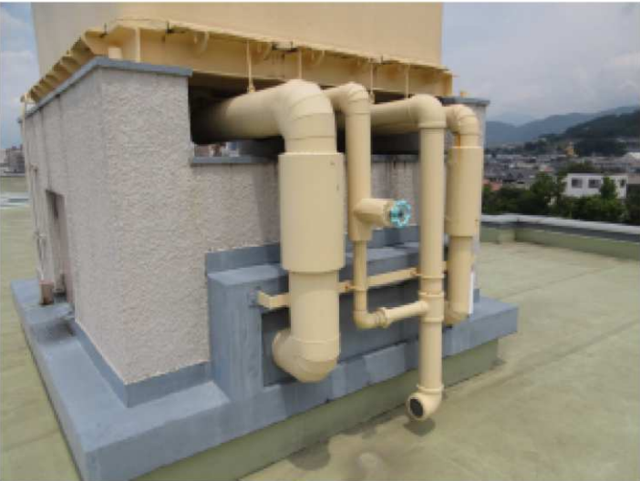
「解体」 ・既存高架水槽（FRP製水槽+配管共） ・鉄骨製架台+鉄筋コンクリート製基礎は既存のまま
