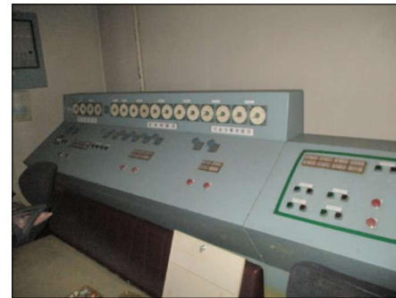
▲⑭電気室操作盤 1基
