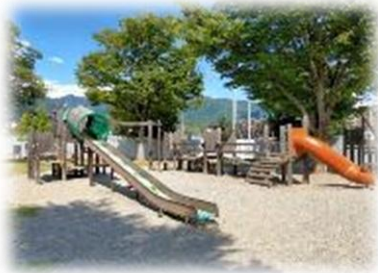
木製遊具の腐食
