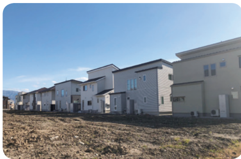
「番小屋」の隣に立ち並ぶ住宅
