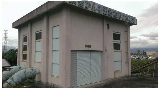
玉諸右岸排水機場
