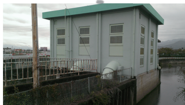
玉諸左岸排水機場
