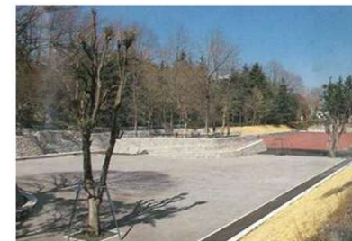
調整機能を有する施設例 江古田の森公園 調節池 (東京都中野区)
