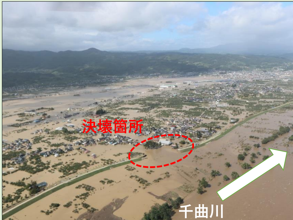
千曲川の氾濫（長野市）令和元年10月
