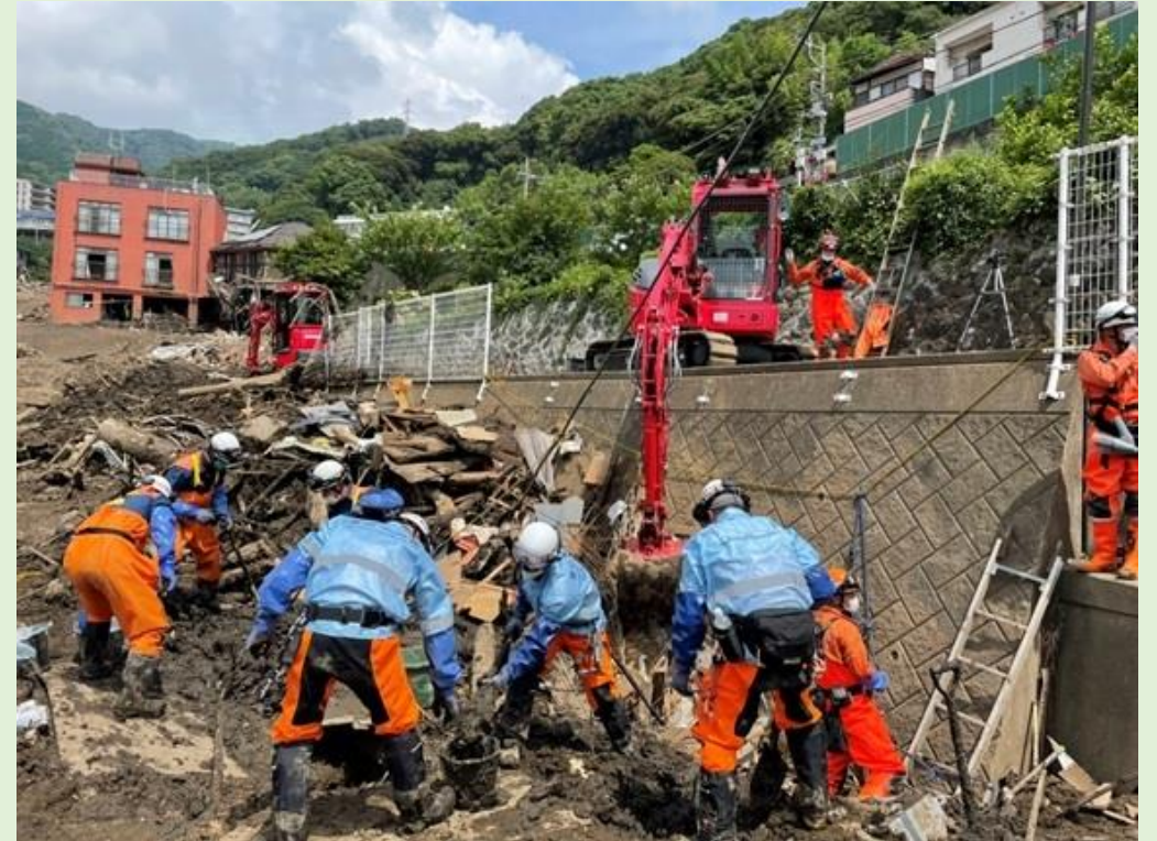
伊豆山の土石流（熱海市）令和3年7月
