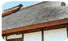
▲トタンだった屋根が、平成31年の修理で元の茅葺に復原された
