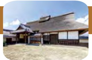
▲主屋を中心に、高室家が最も繁栄した明治41年当時の11棟の建物が配されている
