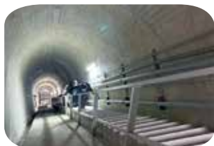
▲監査廊に続く約350段の急階段
