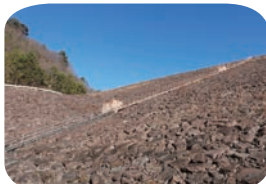
▲約370段の外階段と下から見上げたダム
