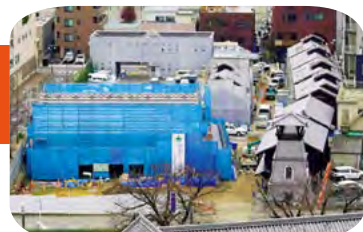
▲舞鶴城公園(甲府城跡)の天守台から、工事中のエリアの様子がよく見えます
