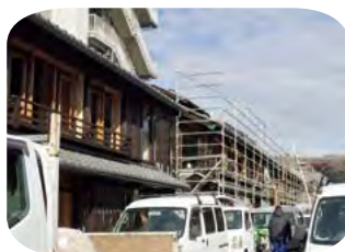
▲木造2階建ての建物9棟に、郷土料理、ジュエリー、着物、ジェラートなど、18テナントが入る予定
