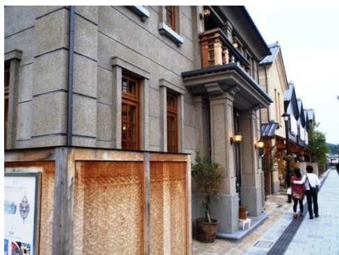
甲府駅北口の『甲州夢小路』
