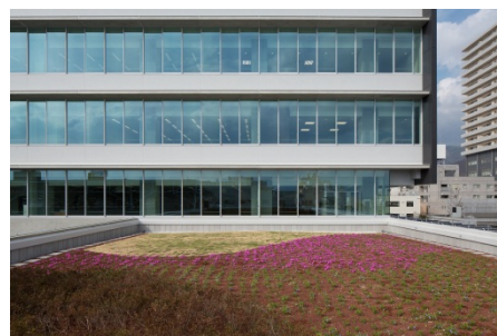
市庁舎の屋上緑化
