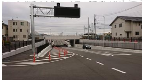
宝二丁目北新線JRアンダーパス工事（整備済）全線開通
